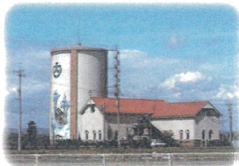
※国営大曲揚排水場給水タンクが目印です。
